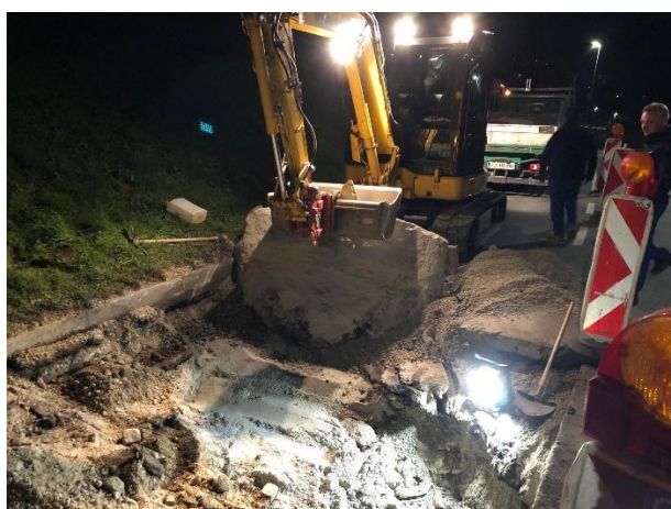
Slika 5: Izvajanje strojnih del pri odpravi okvare na vodovodu
