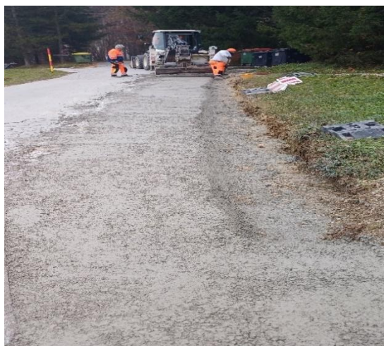
Slika 22: Vzdrževalna dela na cestah v I. 2024
