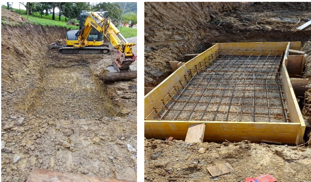
Slika 21: Rekonstrukcija ceste ( izkop in opaž temelja novega opornega zidu)
