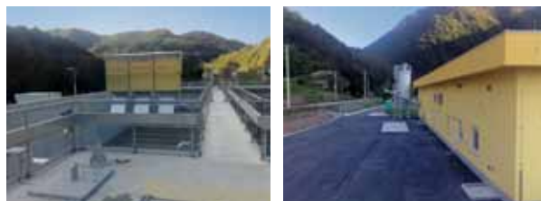
Biološka čistilna naprava za mesto Hrastnik
